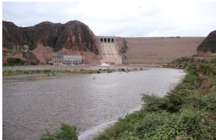
Figura 3. Proyecto Hidroeléctrico El Quimbo.
