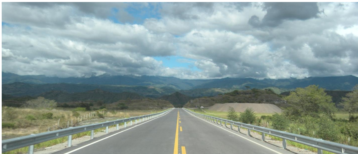
Figura 85. Vía pavimentada. Fuente: Hurtado, 2015
