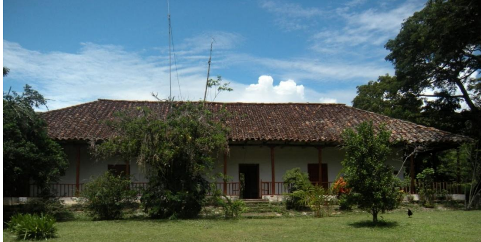
Figura 19. Casa de la finca el Tabor. Fuente: Torres, 2014
