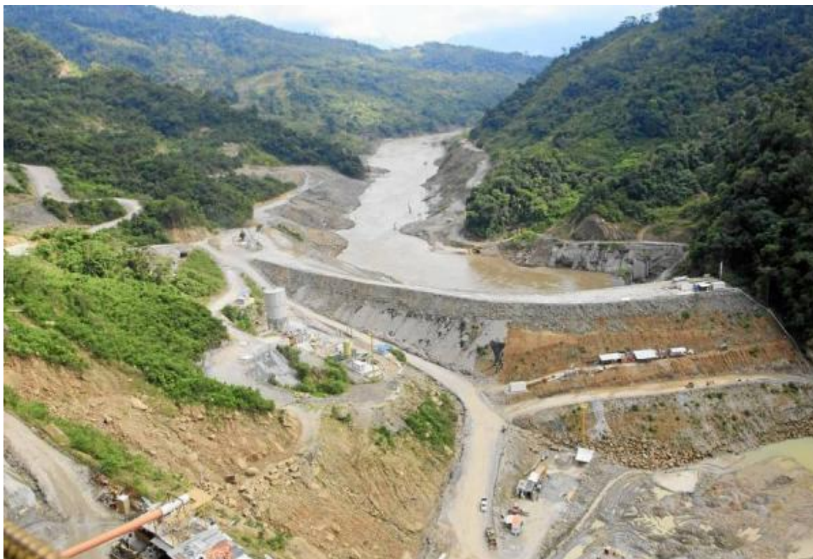
Fotografia 4: Desvio do rio Magdalena para obras (2012)
